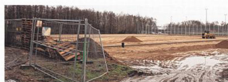
Dieser Platz steht in gut einem Jahr SG Dynamo zur Verfügung.
