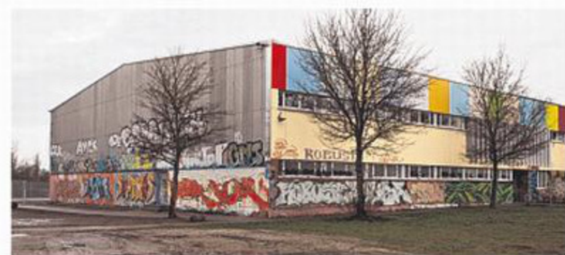
Eines der ersten Gebäude im Sportpark: die Turnhalle.
