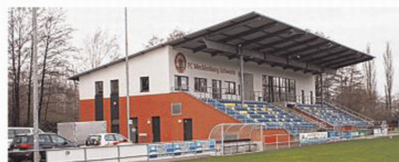
2017 fertiggestellt: Funktionsgebäude mit Tribüne
